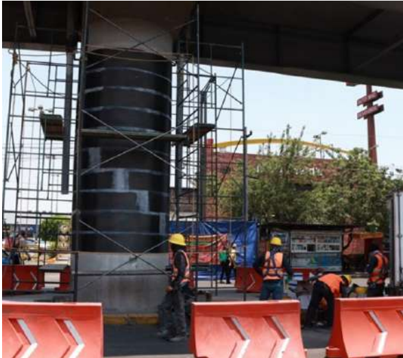
Reforzamiento de columnas
