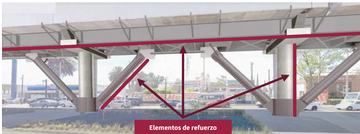
Tramo elevado en reparación
