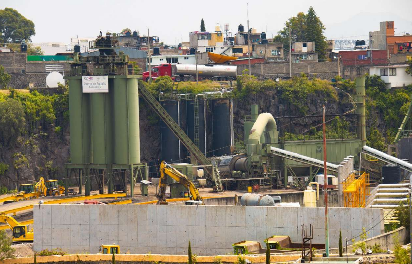
Planta Productora de Mezclas Asfálticas
