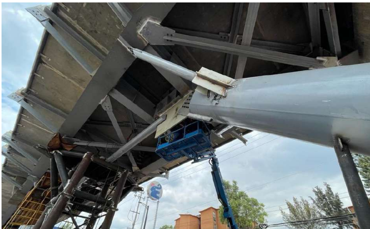
Colocación de puntales
