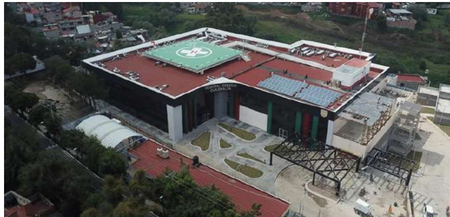
Hospital General Cuajimalpa
