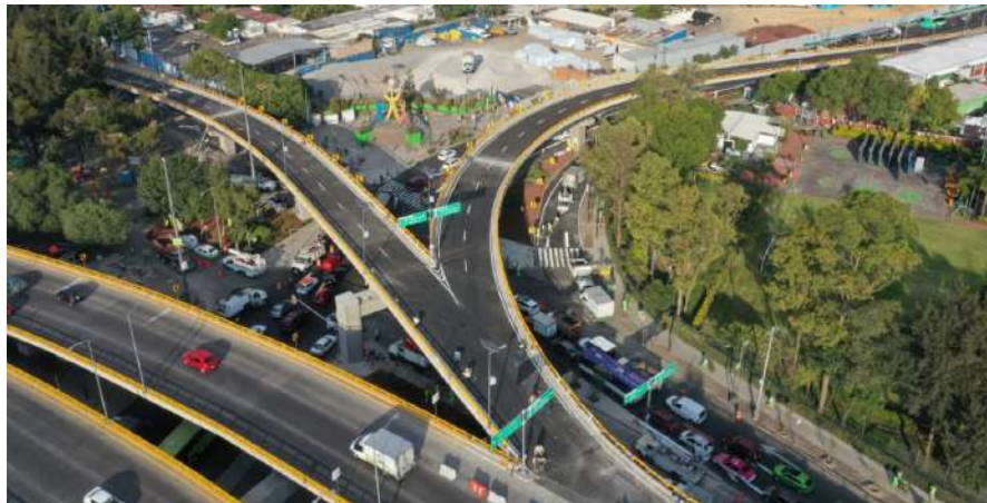
Puente vehicular circuito interior y eje 6 sur
