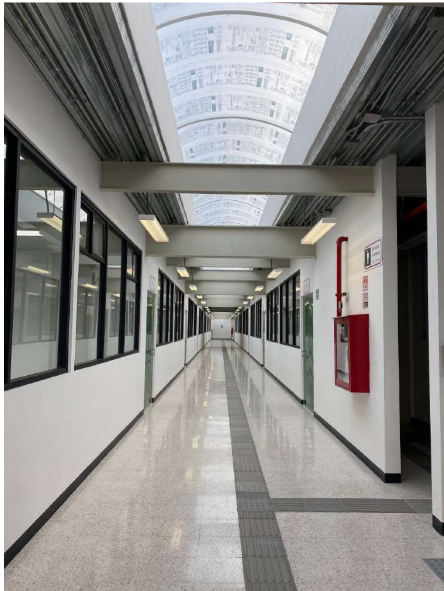
Trabajos de obra en el nuevo plantel Tláhuac II
