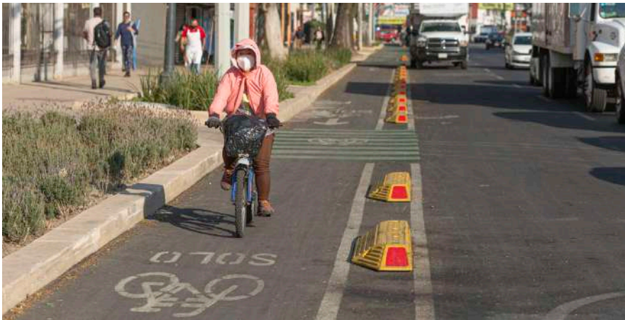
Rehabilitación integral de la Calzada México-Tenochtitlán
