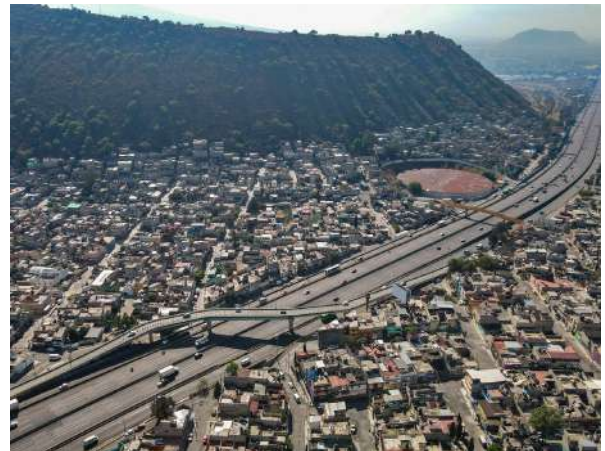
Puente vehicular Emiliano Zapata, sobre la carretera México-Puebla
