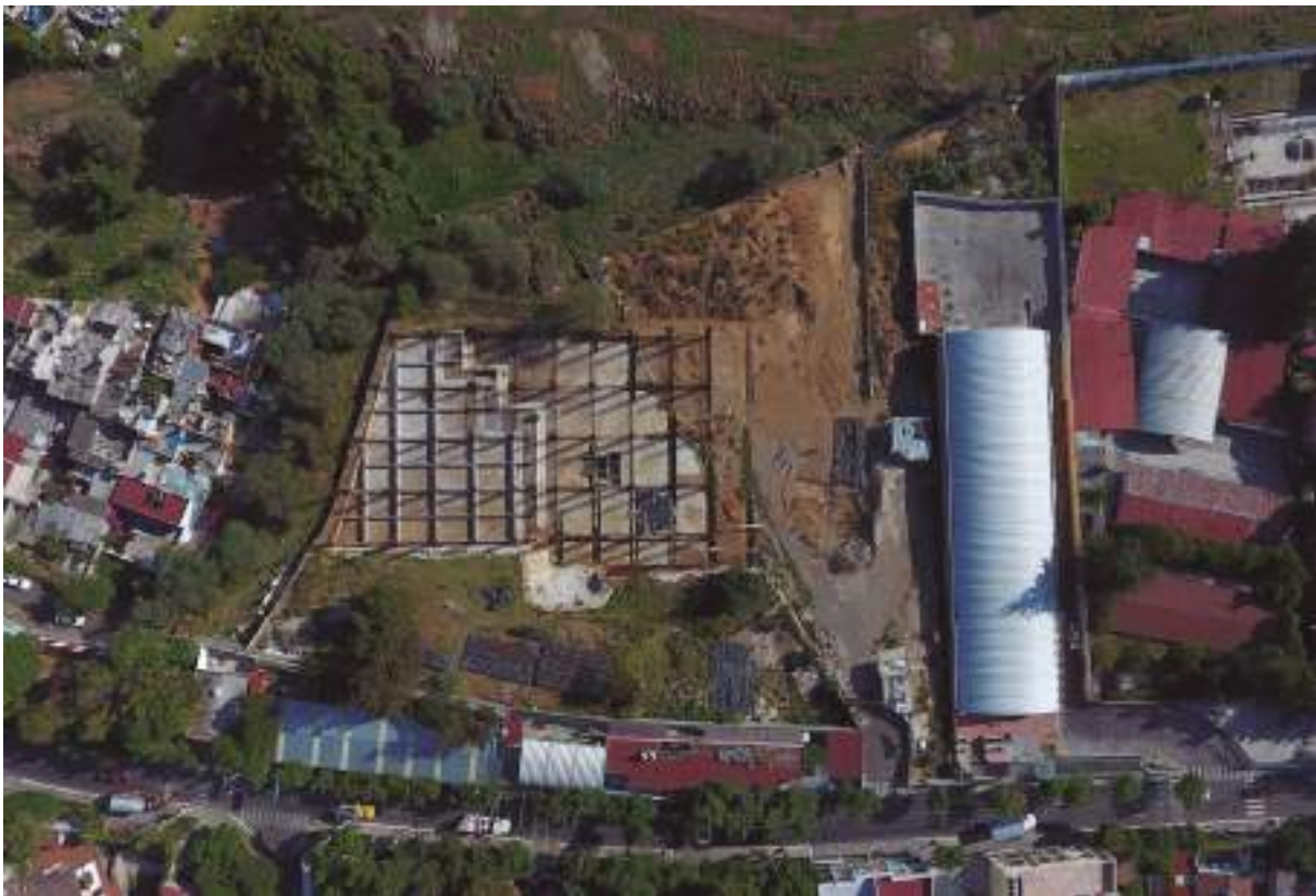
Vista aérea de trabajos de construcción de cimentación.
