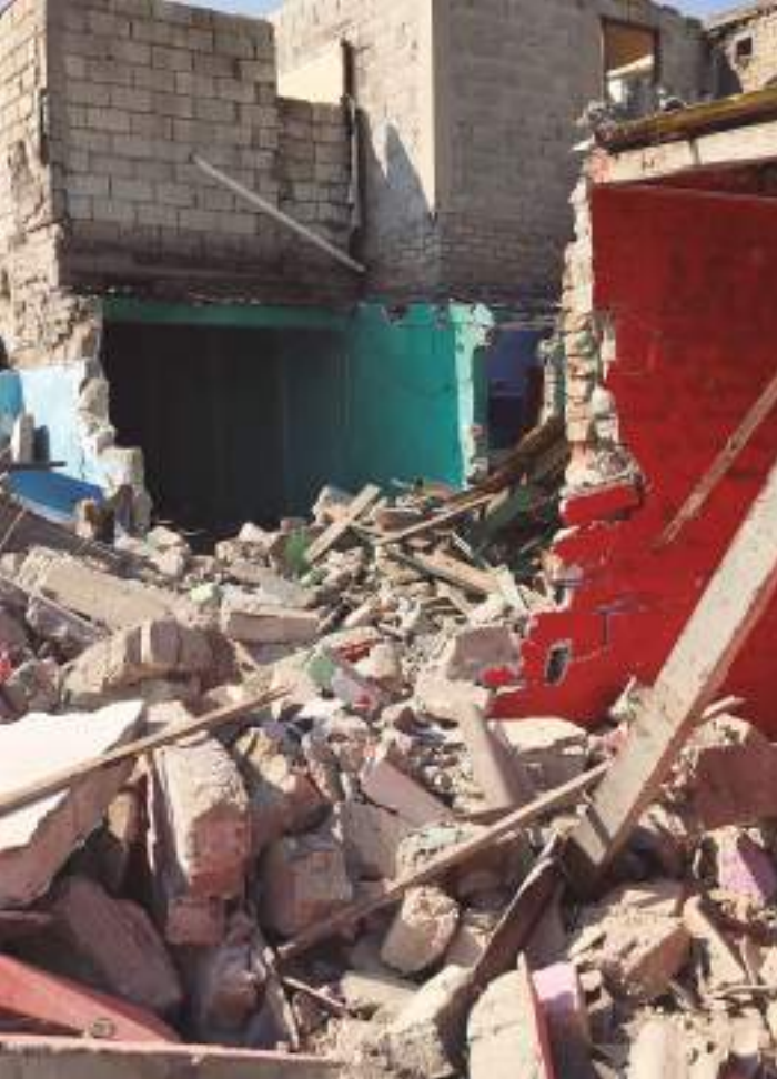
En la imagen se muestra parte de la zona de la Ciudad perdida Tacubaya durante el proceso de demolición.
