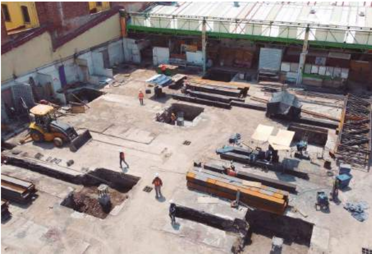
Trabajos de excavación para cimentación de estructura metálica.
