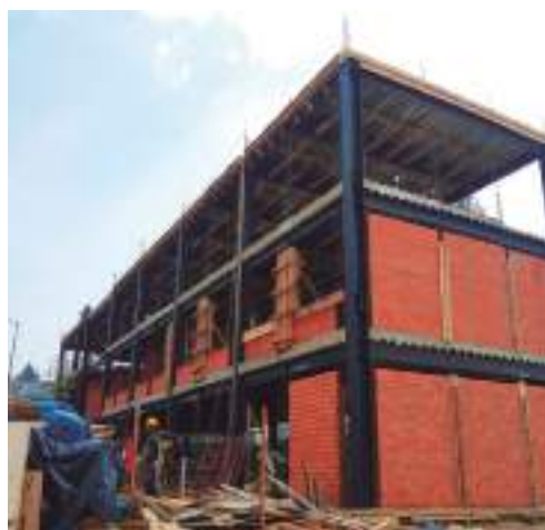
Habilitado de muro en estructura a base de vigas y columnas metálica para el edificio educativo de la Universidad "El Oasis"
