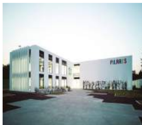
Vista general de los trabajos de construcción en PILARES Gran Canal.
