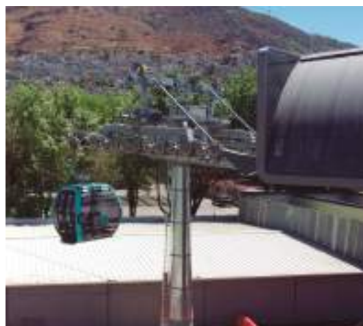
Estación Indios Verdes, pruebas de sistema electromecánico.
