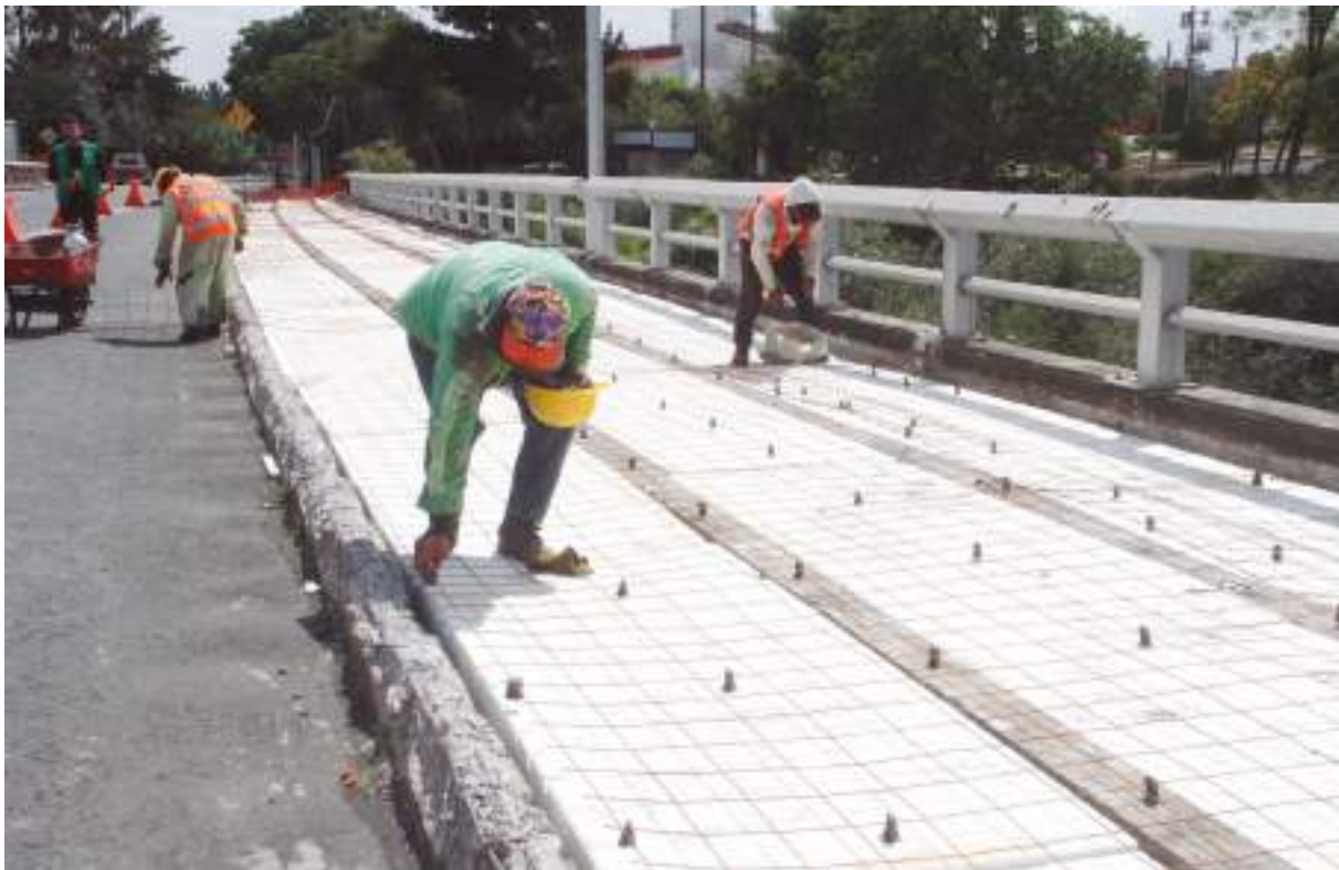
Trabajos de rehabilitación de superficie de rodamiento.
