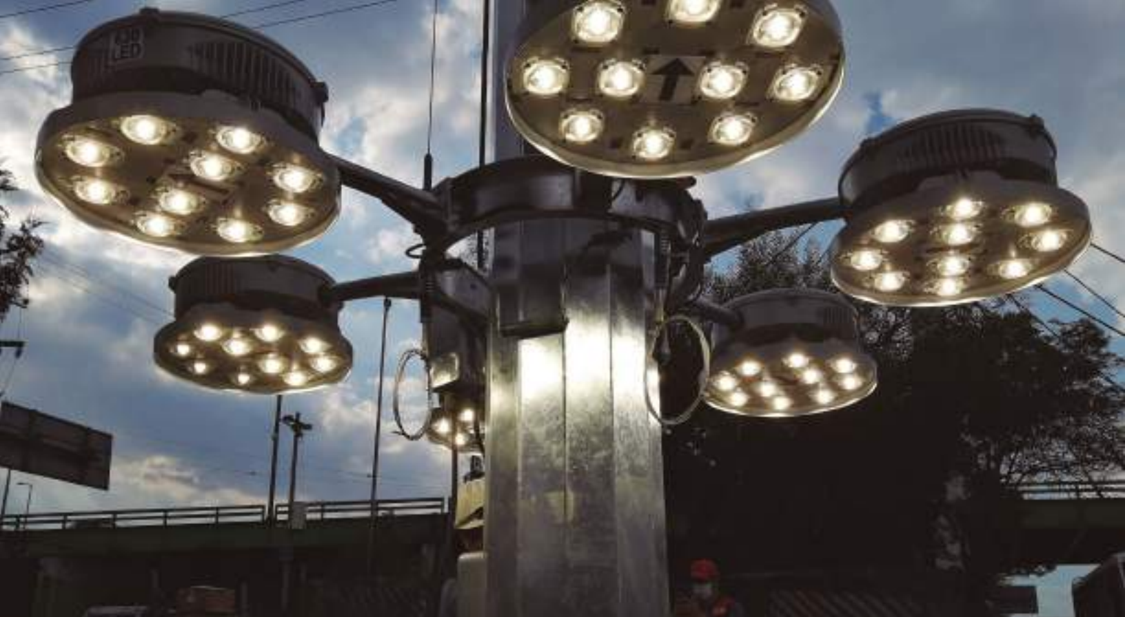
Mantenimiento a superpostes en calzada Ignacio Zaragoza.
