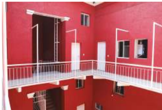
Se muestran los exteriores del predio Republica de Argentina número 87, el cual forma parte de los 18 predios que fueron, serán o se encuentra en proceso de atención a través del Programa Especial de Vivienda en Centro Histórico.
