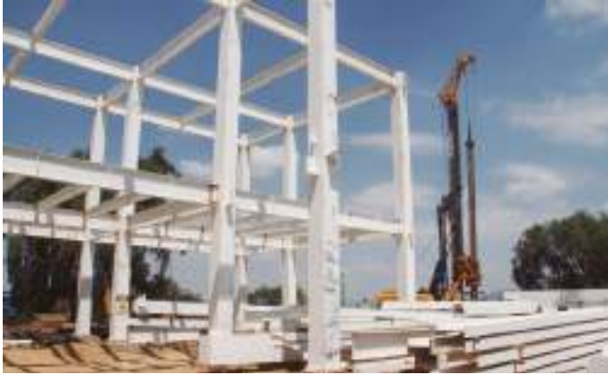
Trabajos de habilitación de estructura metálica.
