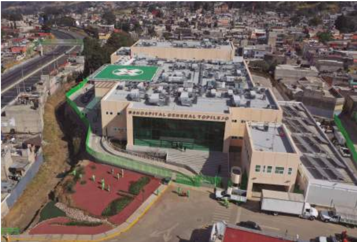
Vista aérea de conclusion de trabajos del Hospital Topilejo.
