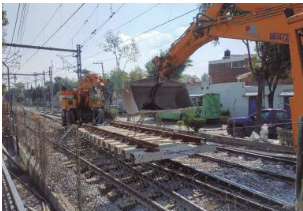
Mantenimiento de vías al Tren Ligero.
