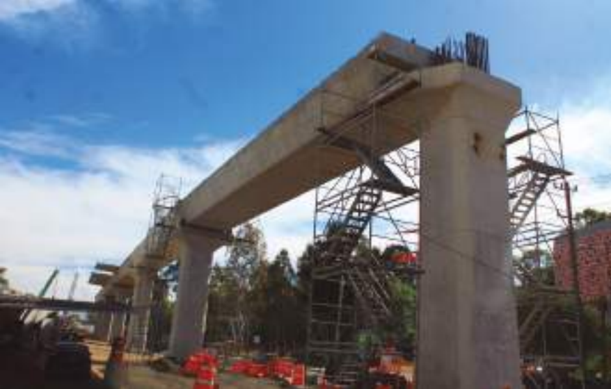
Montaje de traveses prefabricadas de concreto reforzado.
