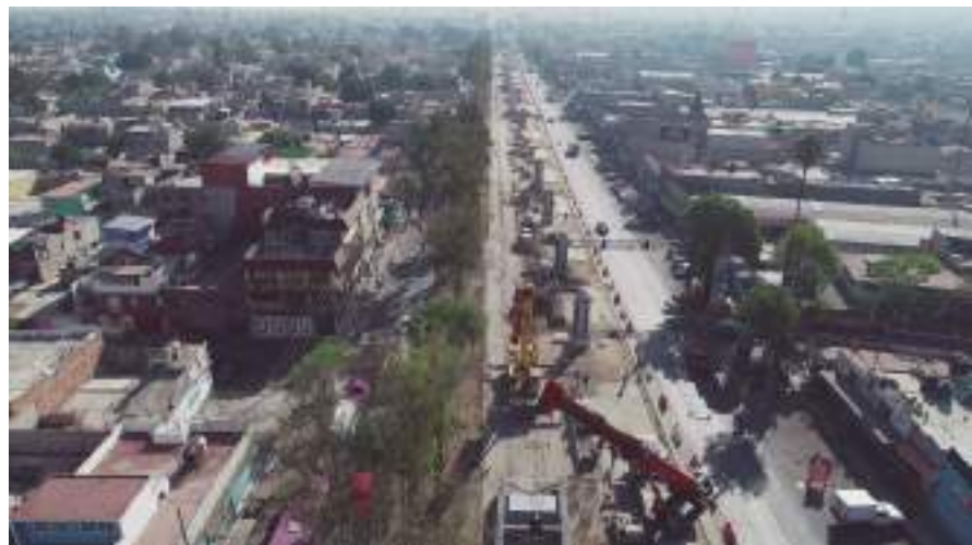
Colocación de estructura metálica.
