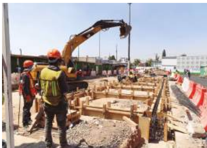
Cimbrado de estación interior CETRAM.
