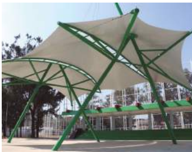
Colocación de velaría arquitectónica.
