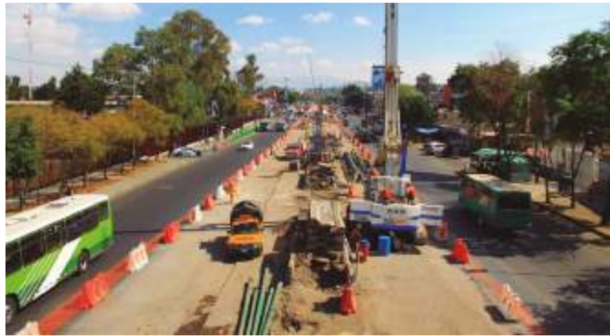
Trabajos preliminares para construcción de cimentación.
