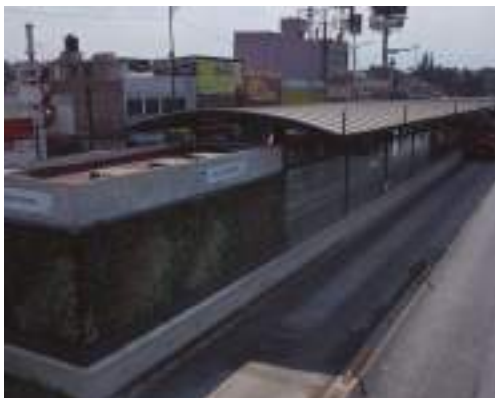
Vista general de la estación Las Bombas del Metrobús Línea 5, segunda etapa.
