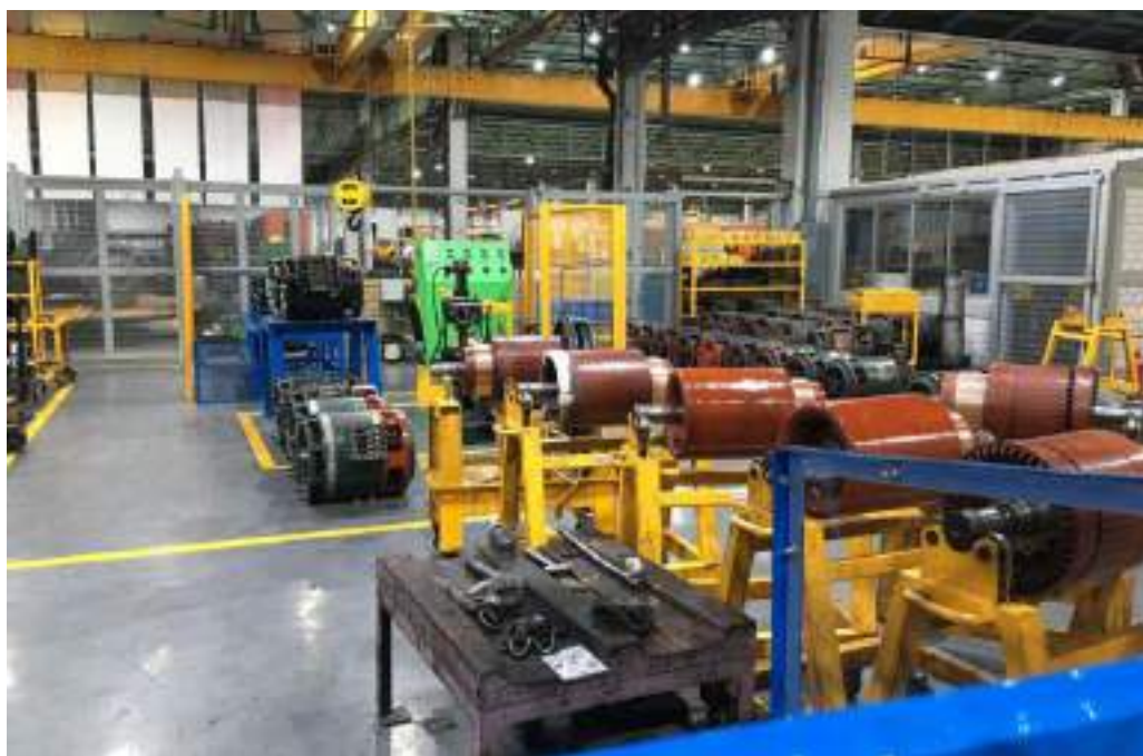
Renovación del taller de Zaragoza.
