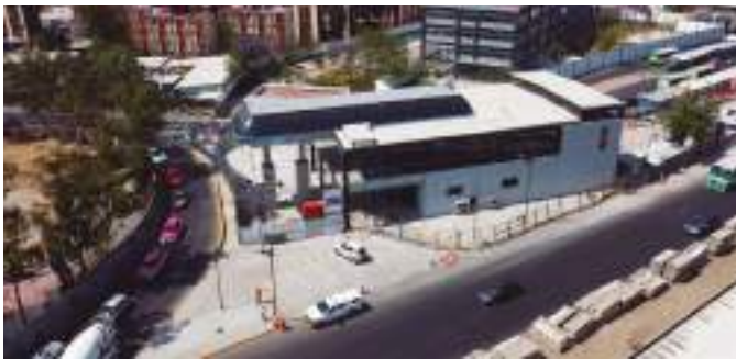
Estación Constitución 1917. Proceso del montaje de elevadores.
