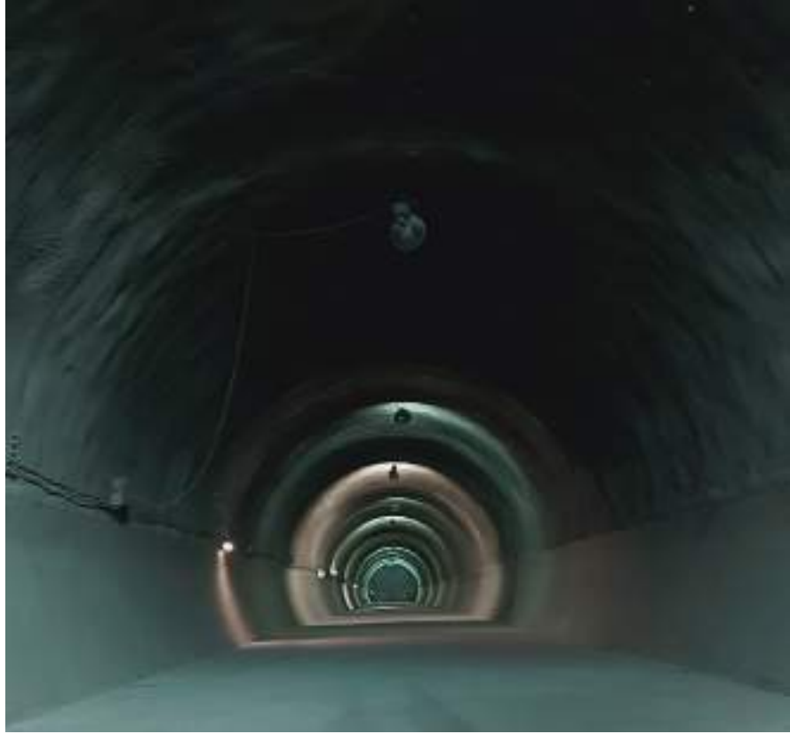
Lumbrera Poniente 83 Muros de Túnel.
