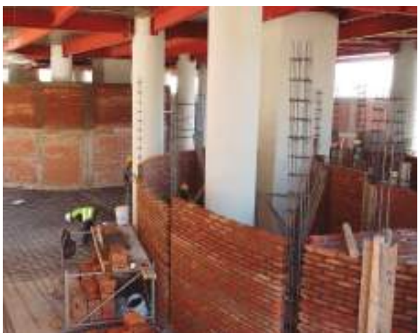
Estación La Pastora. Construcción de muros interiores de estación.
