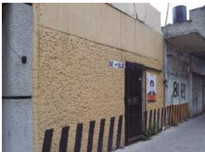
Predio ubicado en Eligio Ancona 83, Col. Santa María La Ribera. Antes de la intervención realizada.
