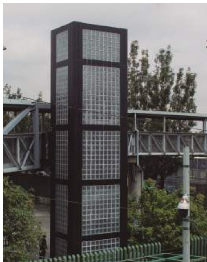
Construcción de elevador para la movilidad universal.
