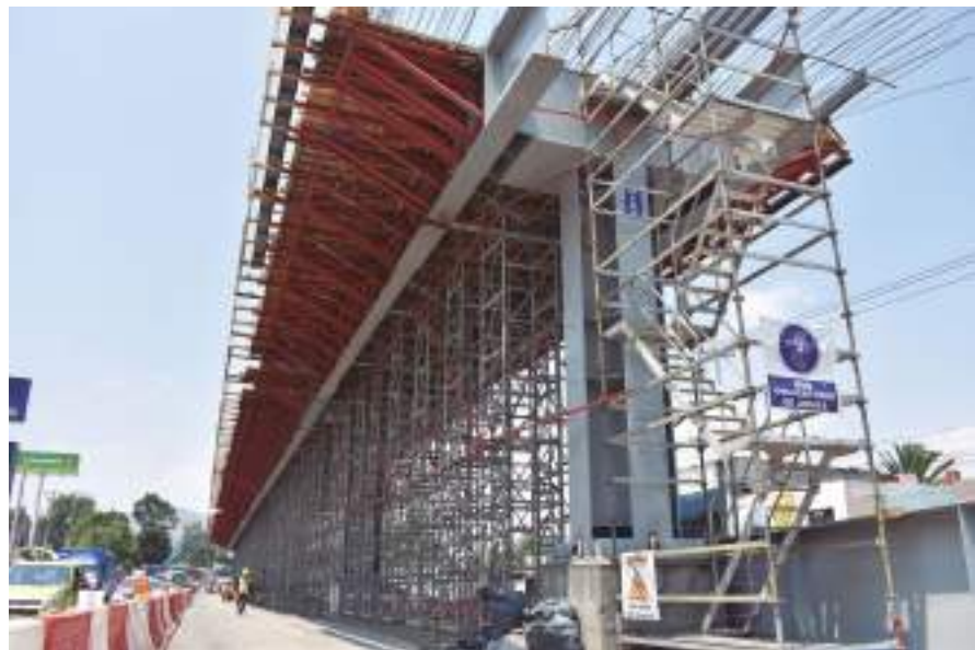
Trabajos en losa para la superficie de rodamiento.
