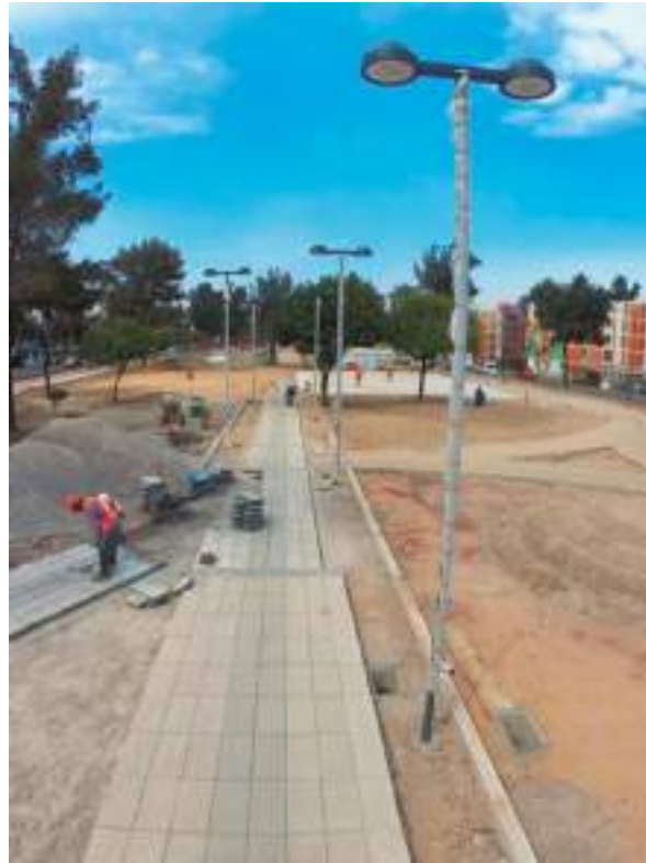
Colocación de banqueta a base de adoquín.
