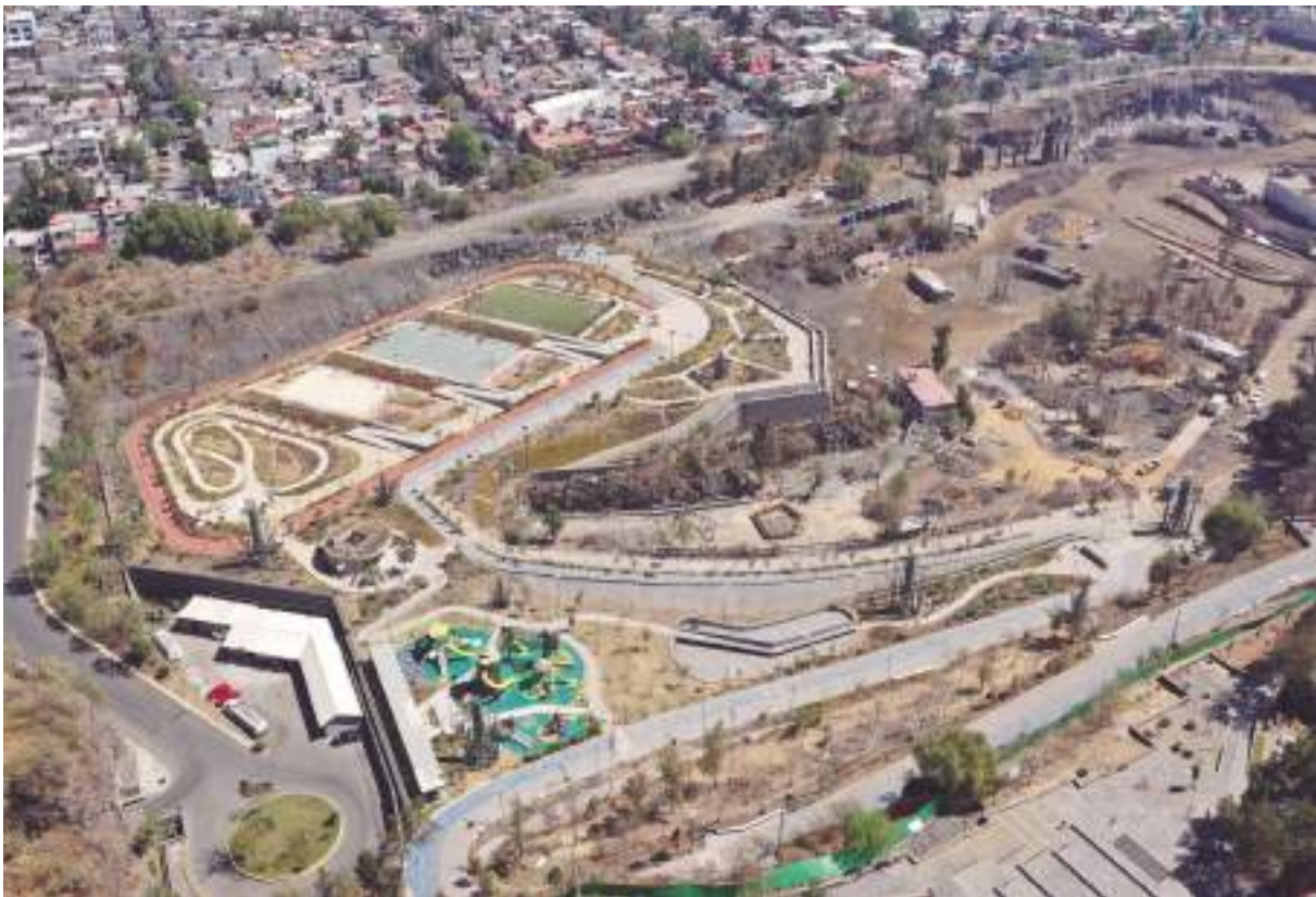
Vista general de la zona a intervenir.
