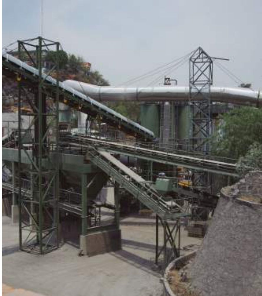
Planta de elaboración de mezcla asfáltica.
