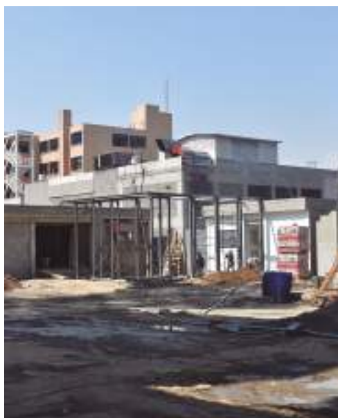
Trabajos de construcción en el acceso principal del Centro Especializado en Medicina Integrativa (CEMI), en la Alcaldía Miguel Hidalgo.
