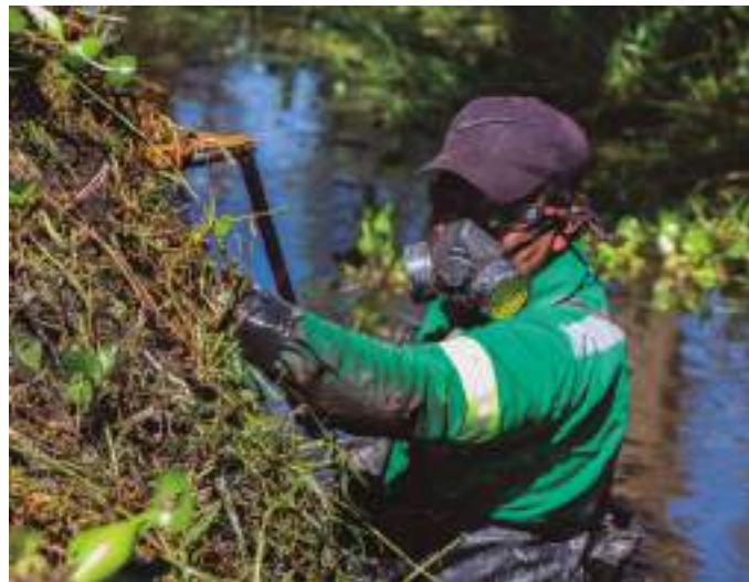
Limpieza de canales en Suelo de Conservación, Tequilo San Bartolo.
