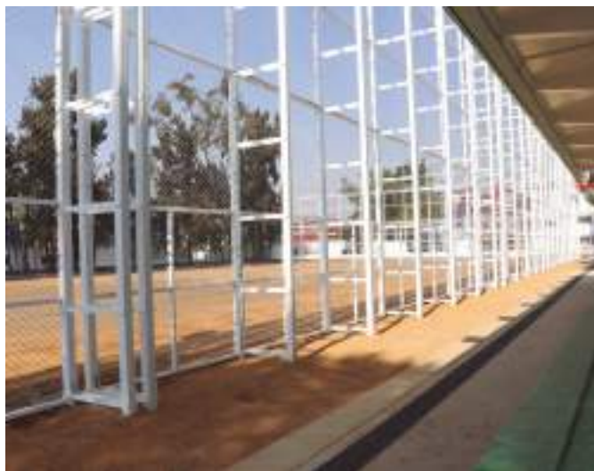
Colocación de estructura metálica para división y protección.
