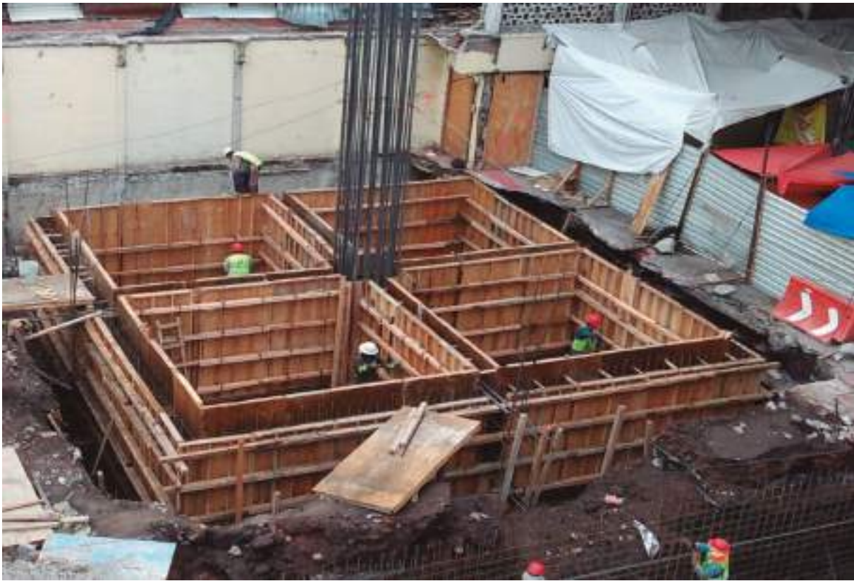
Trabajos de armado de acero para cimentación de Mercado Merced Nave Mayor.
