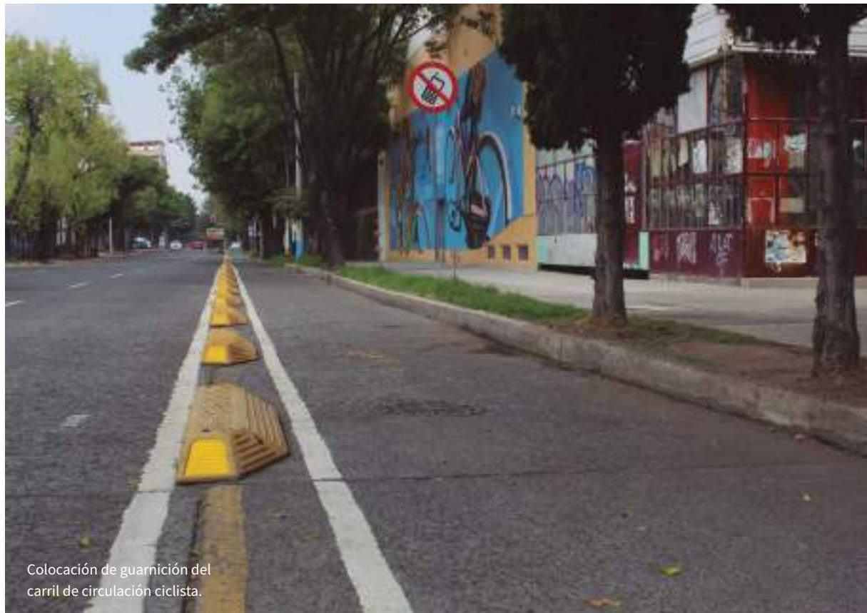
Vista general del carril de circulación ciclista.
