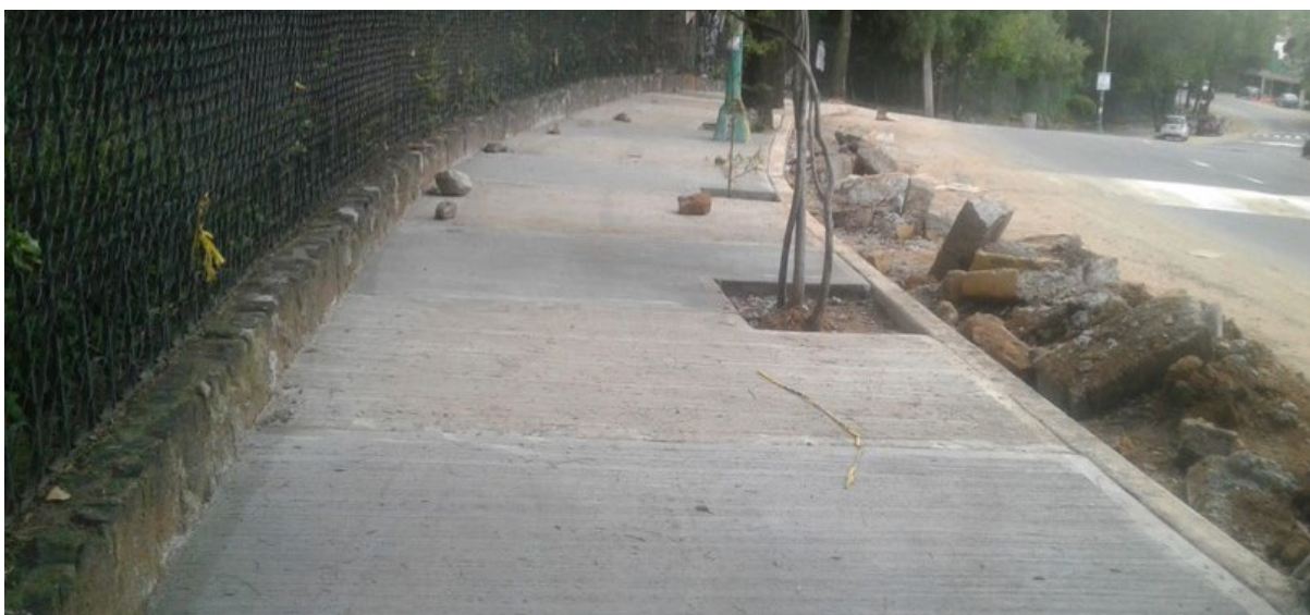
Ciudad Sustentable , rehabilitación de banquetas y guarniciones
