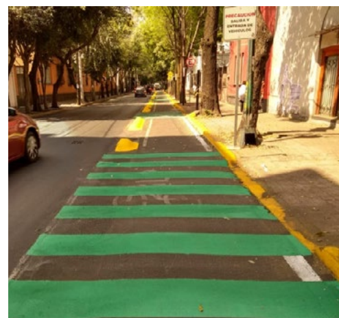
Mantenimiento a ciclovías
