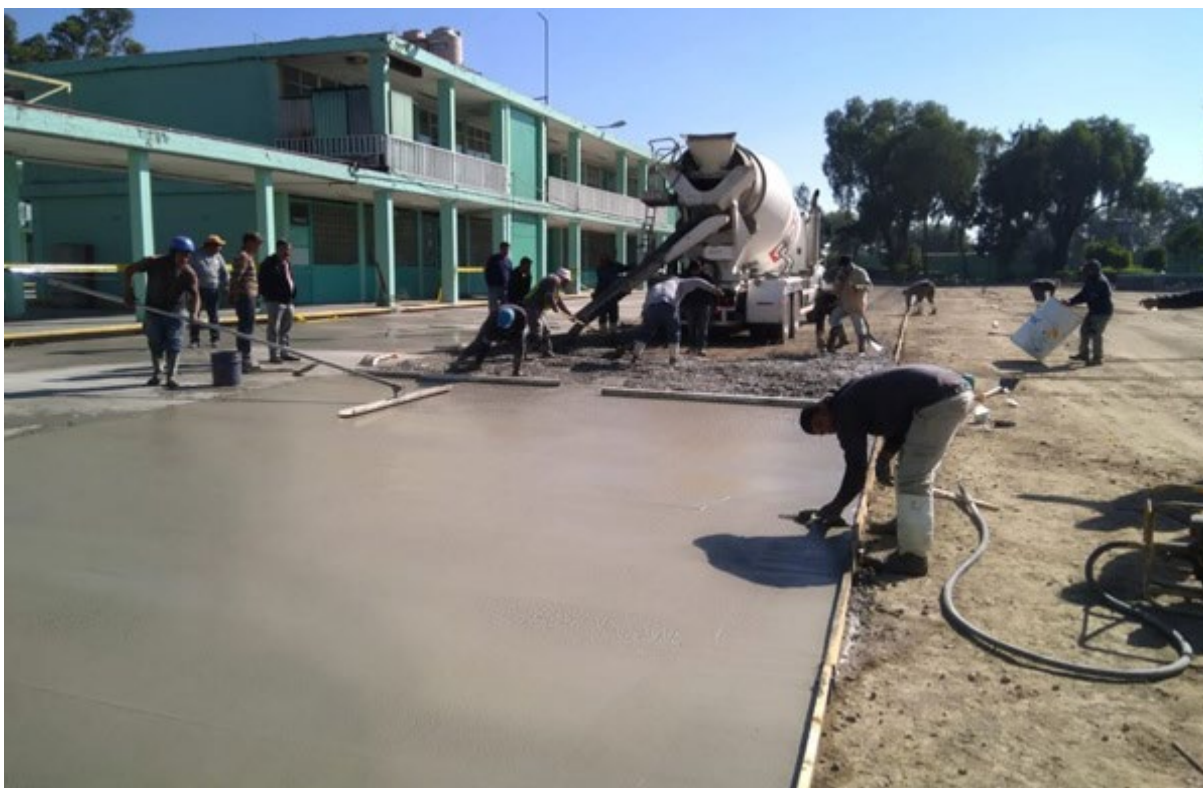
Mantenimiento preventivo y correctivo de planteles
