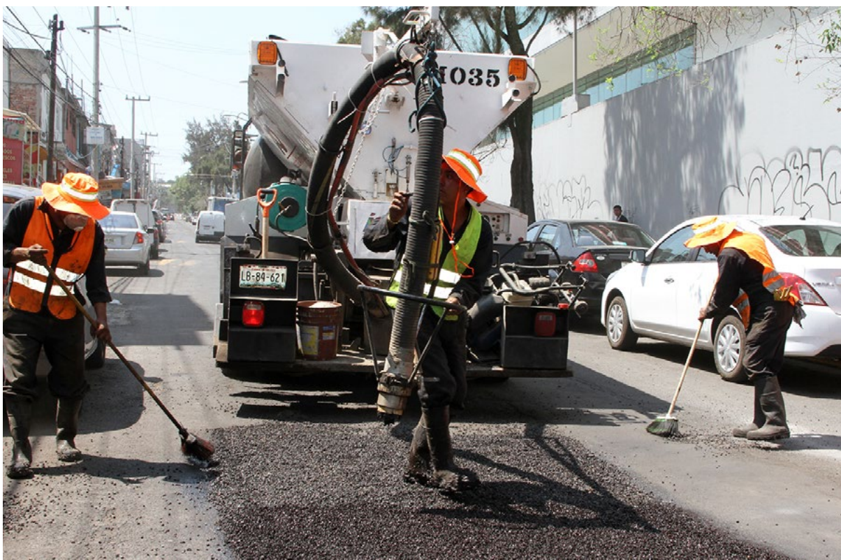
Mantenimiento, Dirección General de Obras y Desarrollo Urbano, alcaldía Álvaro Obregón
