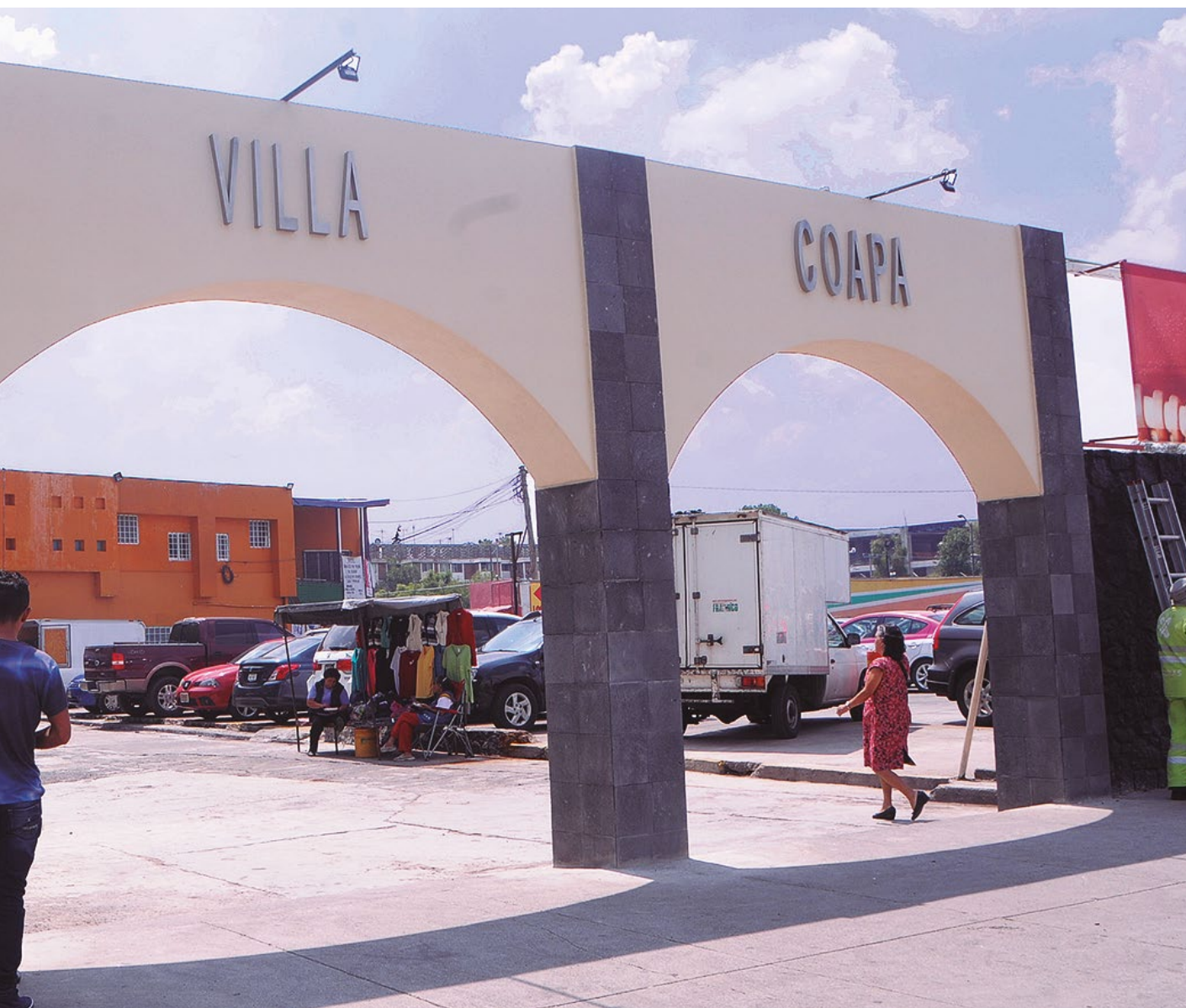
Fachada rehabilitada del Mercado Villa Coapa
