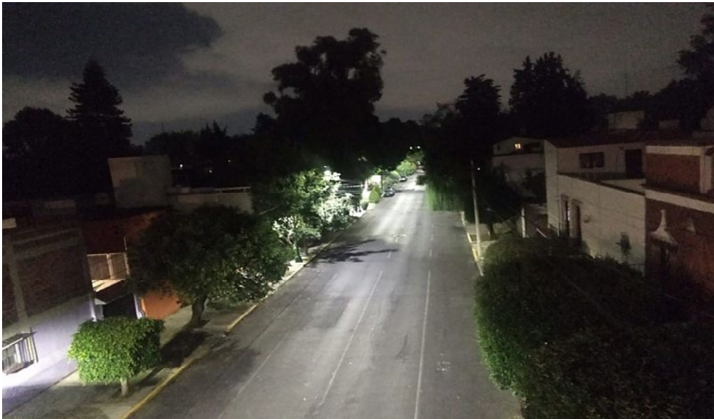
Ciudad Sustentable , rehabilitación de alumbrado público
